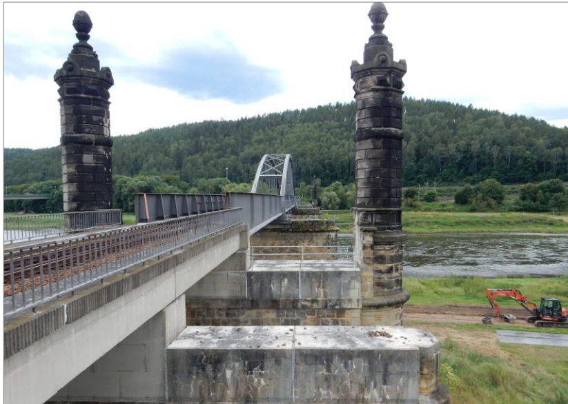
Parallelführung (Ausnutzung „alter“ Breite)
